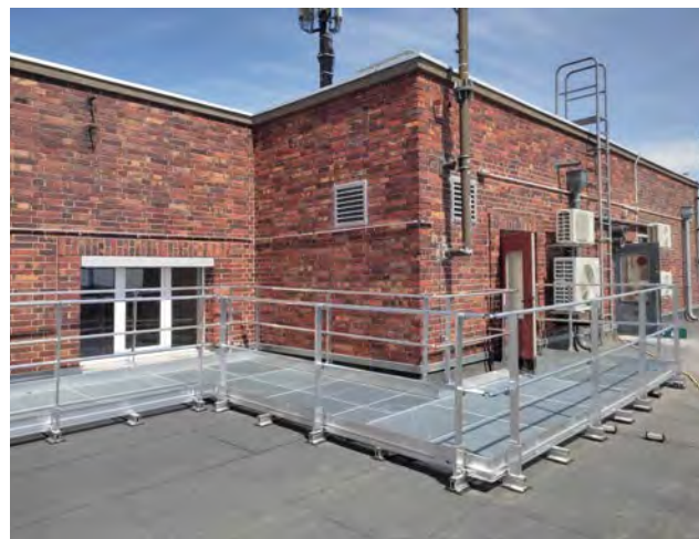
Durchdringungsfreie selbsttragende Konstruktion
